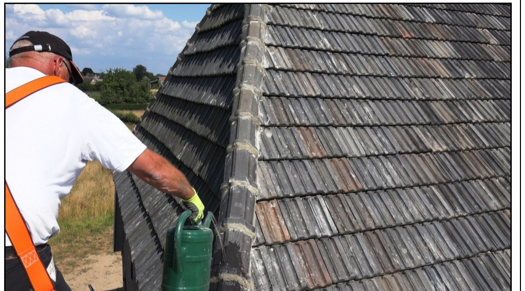
Het leggen van de vorstpannen en het nathouden van de cement om te snelle droging en daardoor onthechting te voorkomen.
