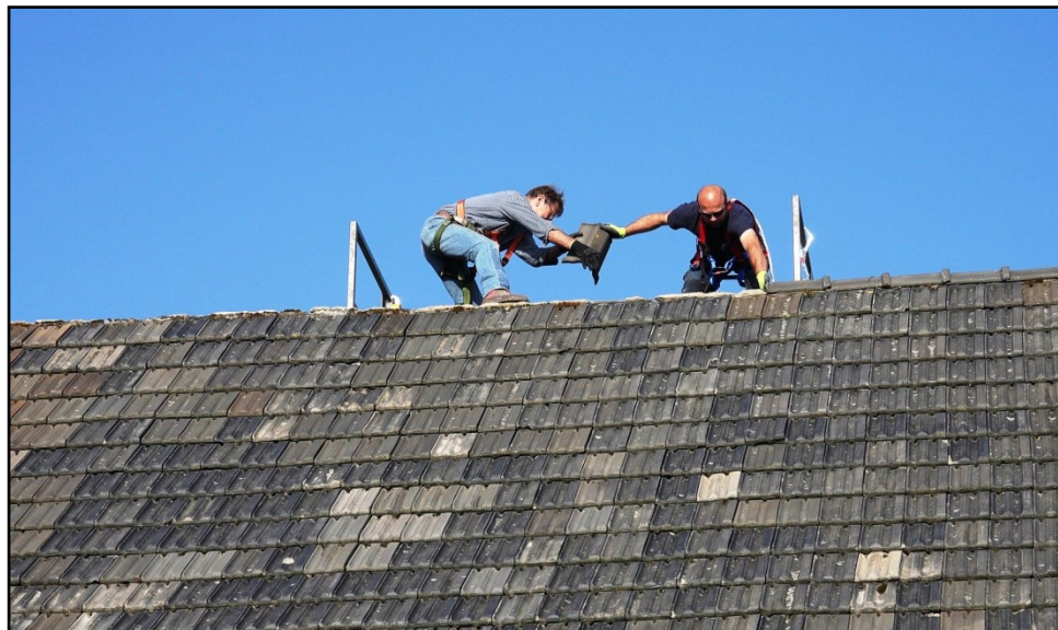
Het leggen van de vorstpannen en het nathouden van de cement om te snelle droging en daardoor onthechting te voorkomen.
