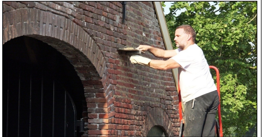
De oude gevels zijn op diverse plaatsen gerestaureerd, slechte voegen zijn uitgebeiteld en opnieuw aangebracht.
