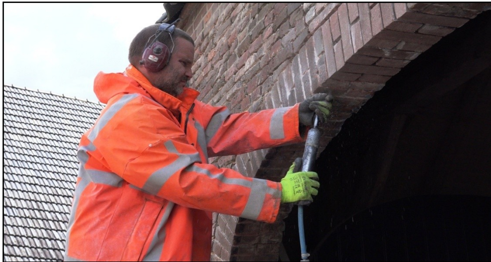
De oude gevels zijn op diverse plaatsen gerestaureerd, slechte voegen zijn uitgebeiteld en opnieuw aangebracht.
